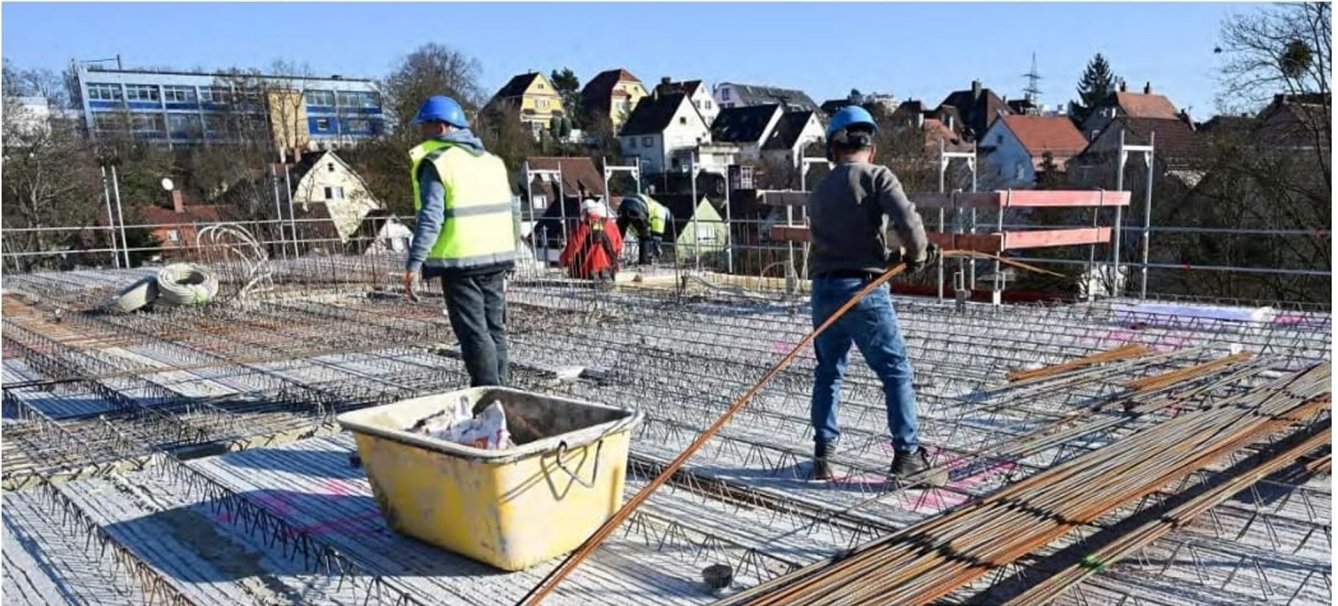
Die Aufträge im Wohnungsbau sind in Baden-Württemberg um über 26 Prozent im Vergleich zum Vorjahresmonat zurückgegangen. Mancherorts bleiben neue Aufträge gleich vollständig aus, wie Unternehmer berichten. FOTO: DPA/BERND WEISSBROD
